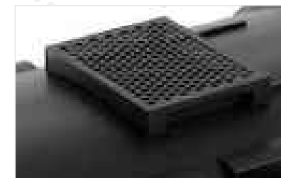
Dachaufsatz mit durchbrochenem Ätzteil umgesetzt
