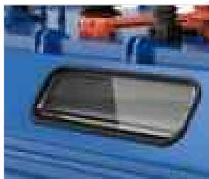
Dachfenster perfekt in der Dachschräge eingesetzt
